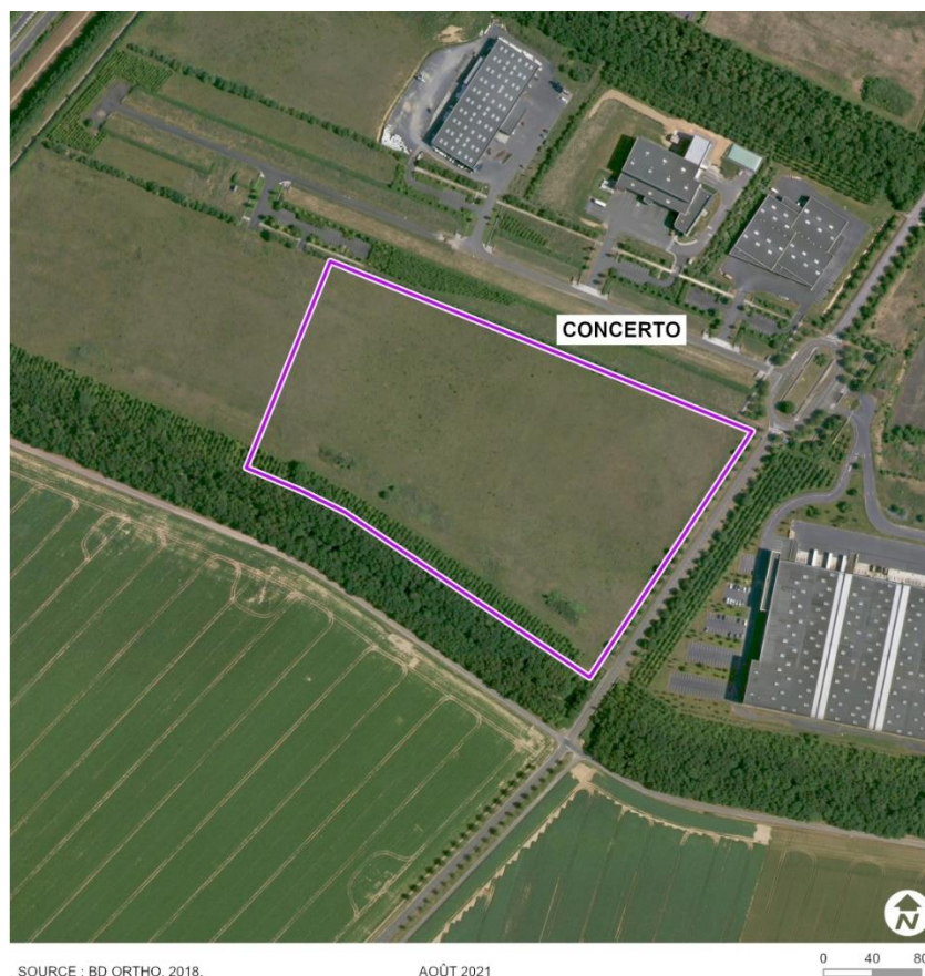
Illustration n° 1 : Vue aérienne du site
